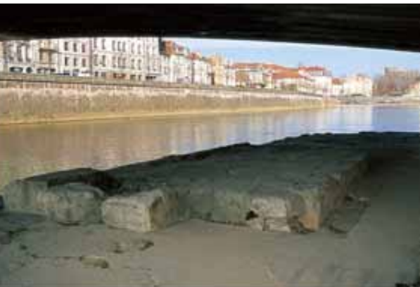
Du pont romain subsiste, sous l'actuel pont Battant, la base d'une des piles sur laquelle on peut remarquer les emplacements qu'occupaient les grosses agrafes.
