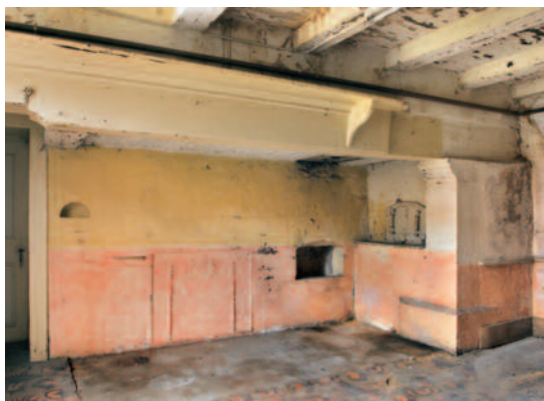
Jougne. Cuisine présentant sous la poutre de la cheminée une plaque en fonte, un cendrier, un four à pain et une petite niche.
