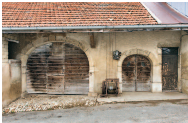
Entre-les-Fourgs. Les entrées (habitation, remise et grange) sont protégées sous l'avant-toit. Les galets de la Jougnena forment un sol pavé devant l'entrée de grange. La déchargeuse, positionnée de vant la façade, était actionnée par un cheval attelé. Elle permettait de soulever un chargement de foin depuis une charrette pour le déposer sur le wagonnet, pont roulant fixé en hauteur. Le foin pouvait ensuite être déchargé dans les élevés.
