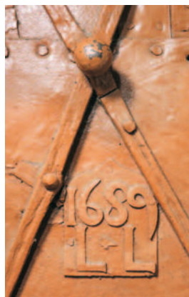
Jougne. Détail d'une porte coupe-feu en métal.
