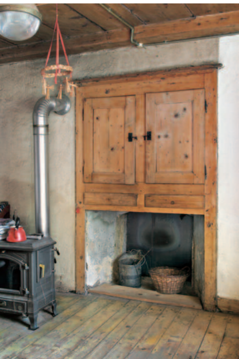
Les Tavins. Détail d'un buffet de platine. La plaque en fonte restituée la chaleur de la cheminée placée au revers du mur.
