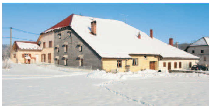
Entre-les-Fourgs. Cette immense toiture couvre quatre fermes. La ventilation du comble permet au foin de sécher. La façade est protégée par des tavaillons.
