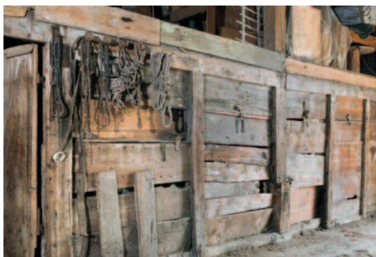
Jougne. La cloison entre la fourragère et l'étable est percée d'ouvertures, les crèches, qui se ferment à l'aide des bou-rancles. Le foin passe de la fourragère aux bêtes par ces crèches.
