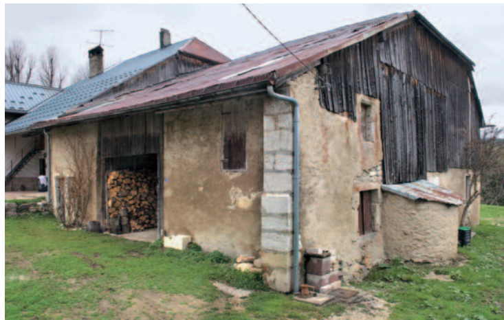
Entre-les-Fourgs. Ferme avec avant-toit, mur pare-vent, cache-bois et talvane. Le four à pain est en saillie sur la façade latérale.
